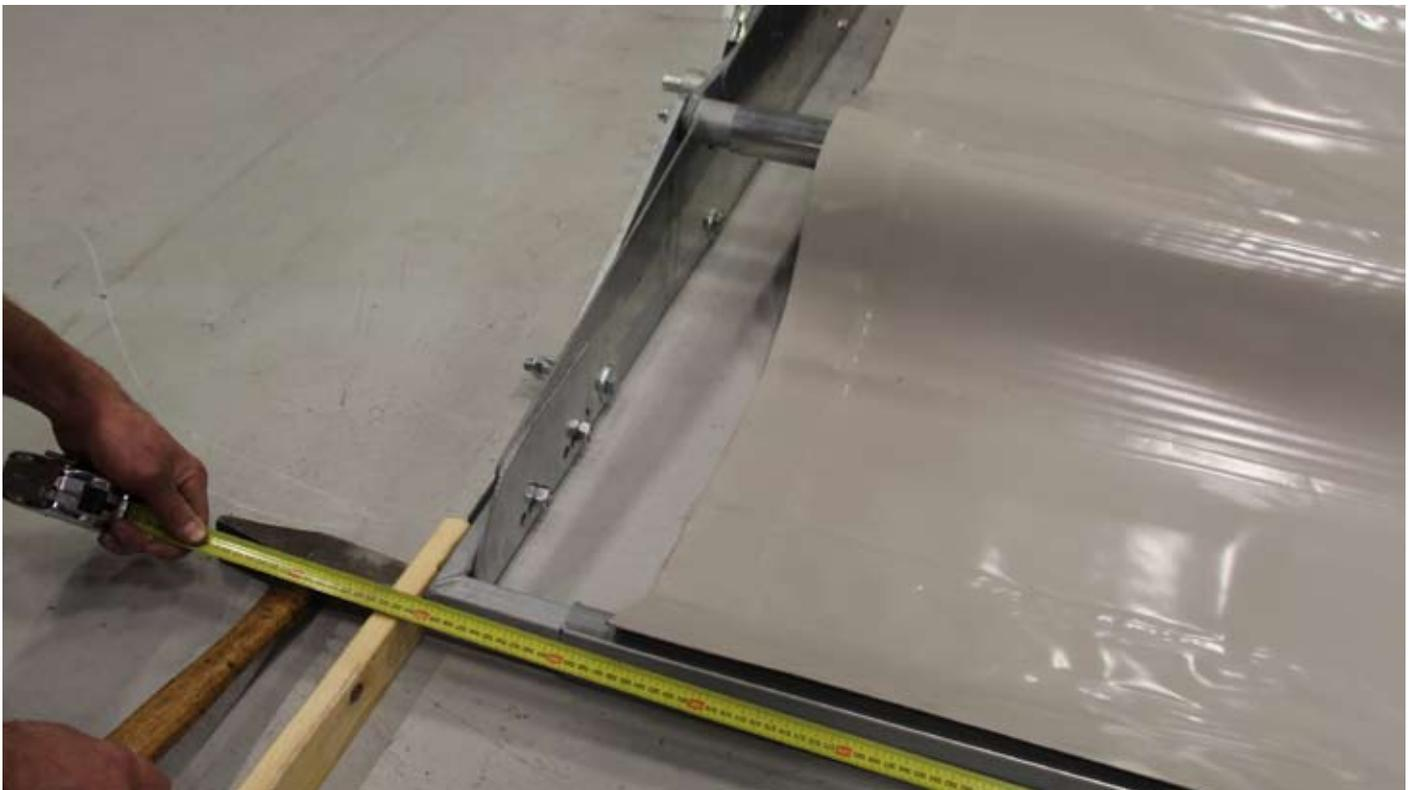
**Soyez précis dans vos mesures avant de percer des trous et de visser ensemble le système, commencez par le bout d'un montant.**
