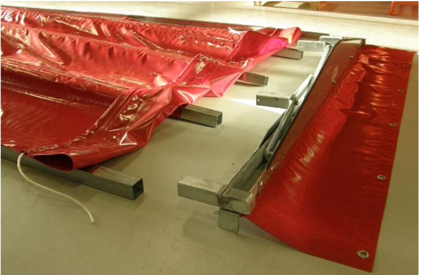
Wenn Sie einen Planenüberhang am Giebel haben, montieren Sie diesen bevor Sie den Giebel auf die Rohre aufchieben.
