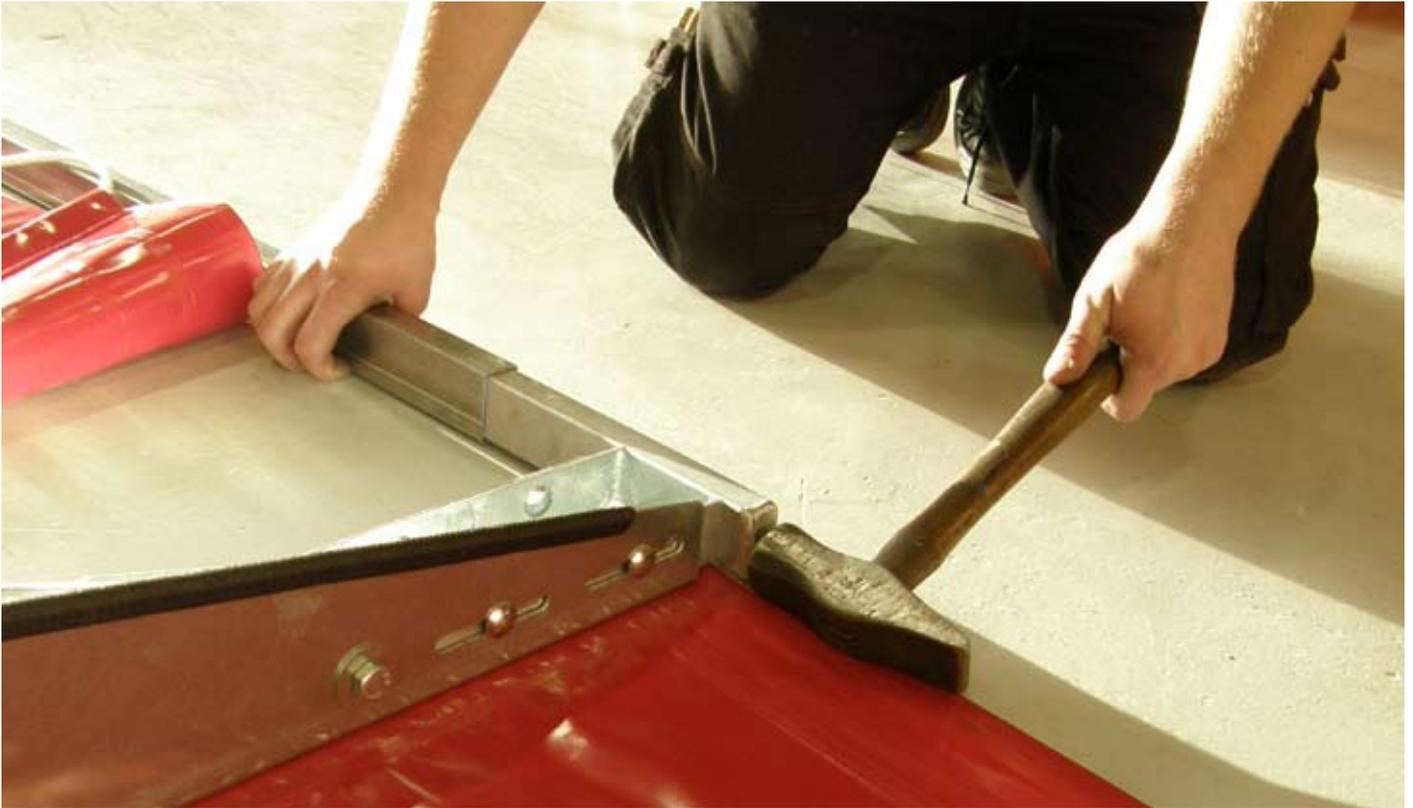
Verwenden Sie einen Hammer um die Rohre in den Giebel einzutreiben.
