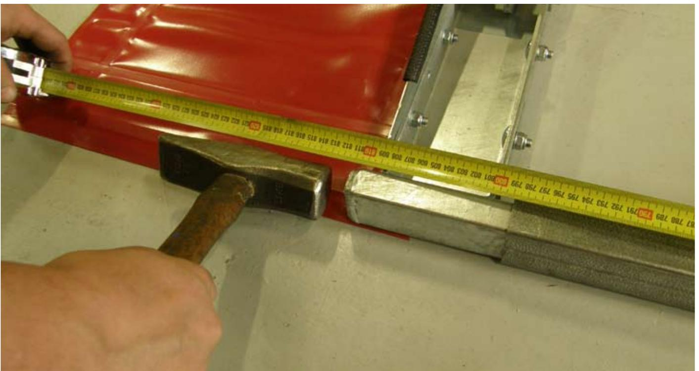
**Kontrollieren Sie die Maße des Systems bevor Sie die Löcher zur Verschraubung bohren.**
